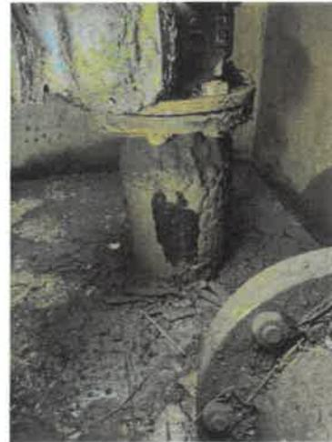
L'état de ces piquages est inquiétant mais ce constat ne permet pas de présager de l'état de la conduite enterrée. En effet, le tronçon de canalisation permettant la pose des purgeurs traverse une dalle béton en fond d'ouvrage de visite sous laquelle se trouve la canalisation DN 1000 mm enterrée.
